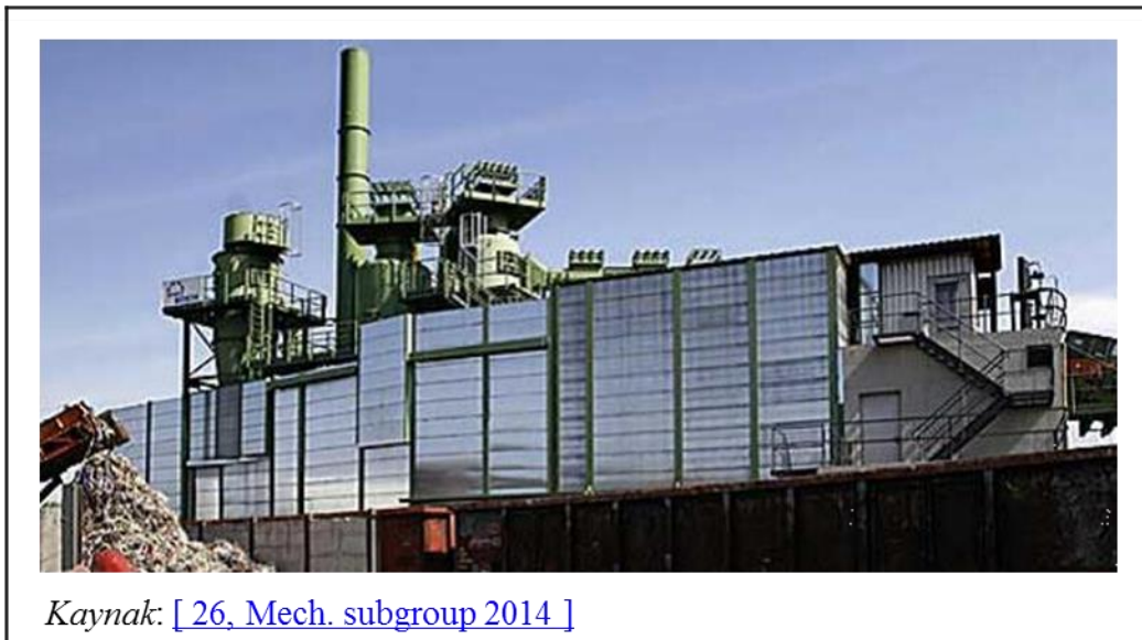
Şekil 3.23 Schrott-Bosch GmbH, Almanya kırıcısında koruyucu perdeleme
