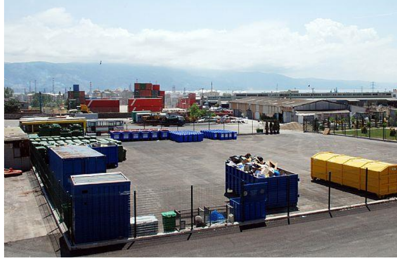
Şekil 4-19 Körfez Belediyesi Atık Getirme Merkezi, İzmit
